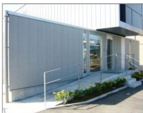
▲玄関前のスロープ
